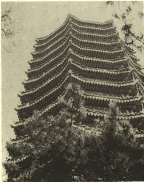
北京市近郊にある古塔を模して作られた北京大学供水塔
