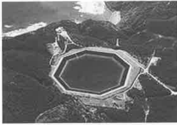
やんばる海水揚水発電所
