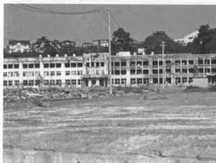
石巻の門脇小学校は津波のあと、火災にも遭った
