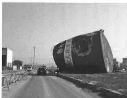
缶詰工場の広告塔の残がい (石巻)
