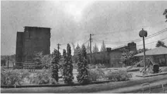
左側の建物が本校舎。現在は取り壊され、更地となっている。 確実に震災によって変わってしまった風景がある。
