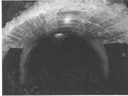
第2地区T5一部コンクリート補強されている
