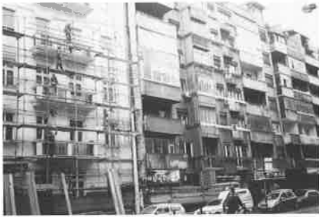
写真1 街中ビル修復中の現場
