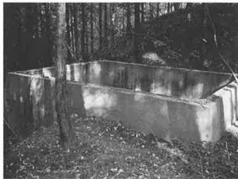
第4地区貯水池様コンクリート構造物
