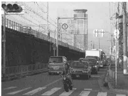
大雨が降ると、この線路が堤防となった。 JR吹田駅付近
