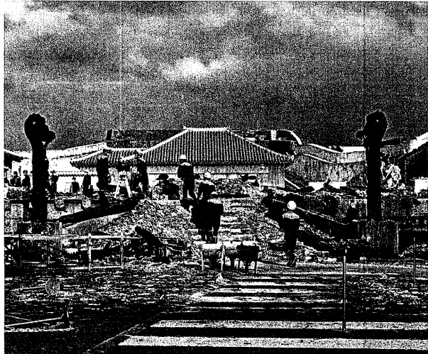
2019年10月31日の火災で焼失した首里城正殿前に焼け残った大龍柱
