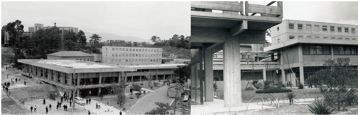
62年建設誠之館第1号・2号・3号館
