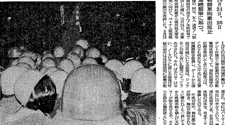
〈写真〉米軍戦車搬出阻止連闘闘争に起る (10月24日相模原補給廠前)
