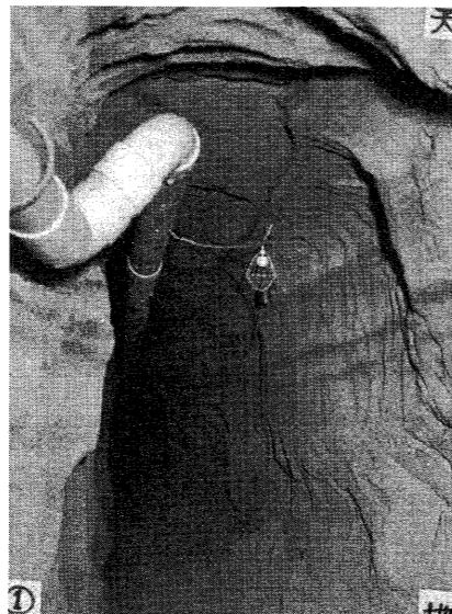
トンネルにつながる縦穴
