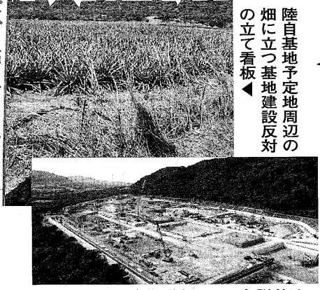
▲石垣島に建設中の陸上自衛隊ミサイル部隊基地
